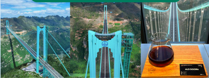
全透明電梯直冲雲霄；高橋塔尖冠軍咖啡打卡
